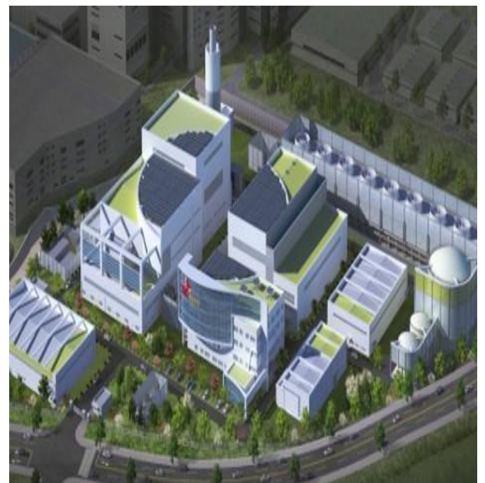
스마트에너지센터 건설 Project (이천)
