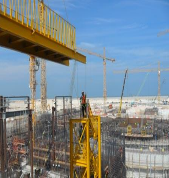
신고리 원자력 5,6호기 철골공사 1공구
