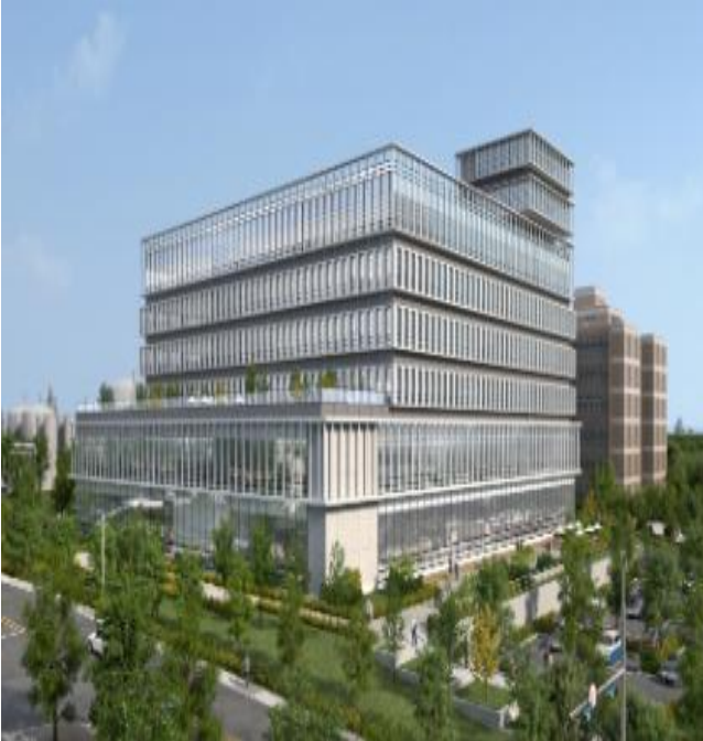
울산CLX 행복 Community Center 건립공사 중 철골공사
