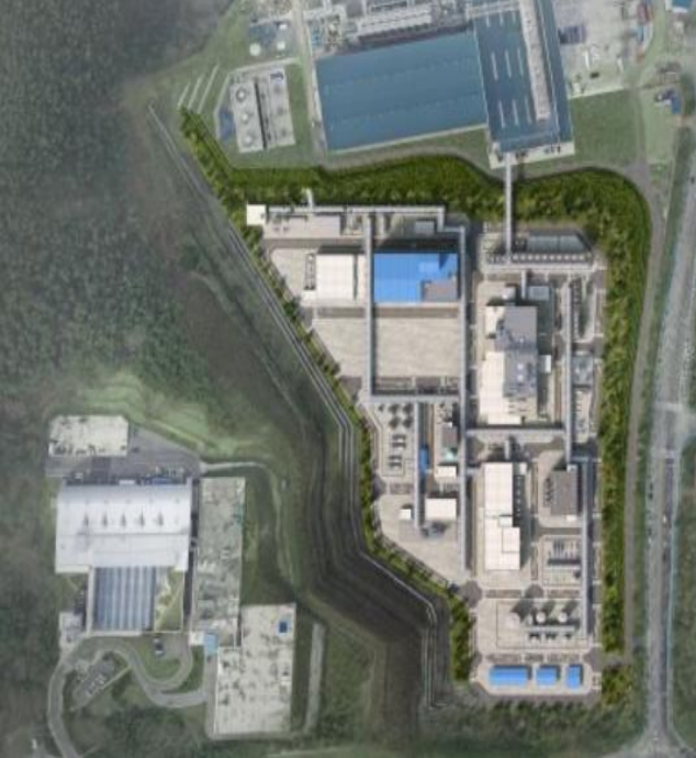
화학 대산 PBAT Project Steel Structure 제작 및 납품
