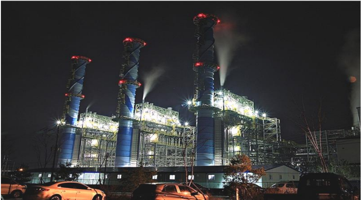
오성복합화력 Project 철골공사
