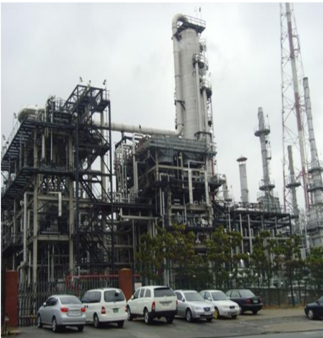
LBO 배관 철골공사
