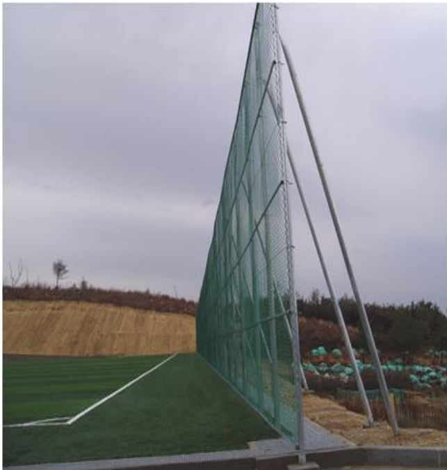
운동장 펜스 설치공사
