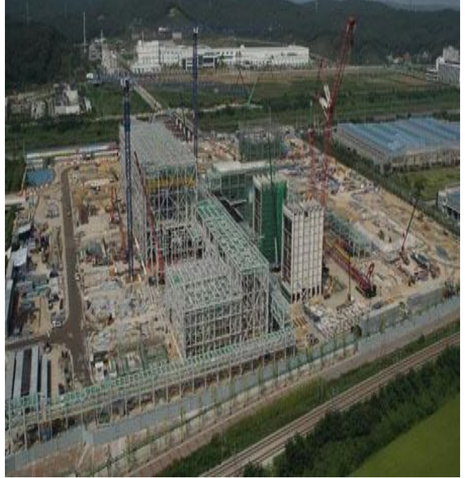
장문 복합천연가스 발전소 중 철골공사
