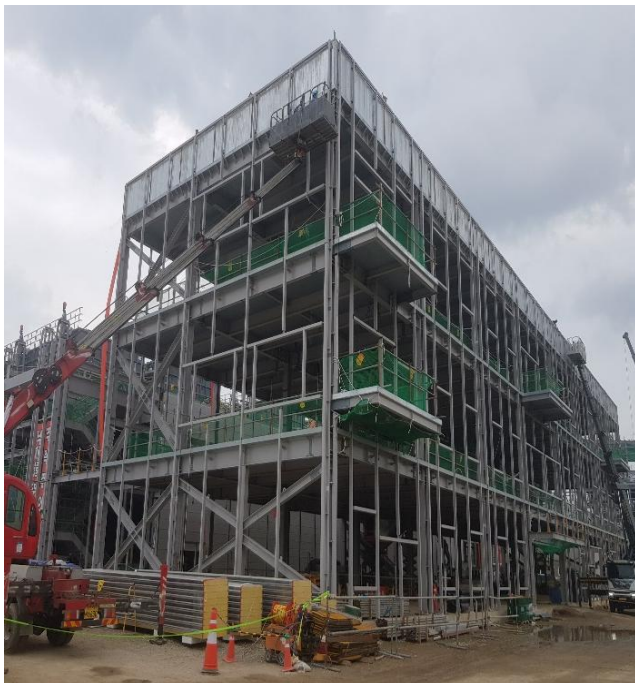
EVBM스크라바 환경설비 설치 및 토건공사 중 철골공사
