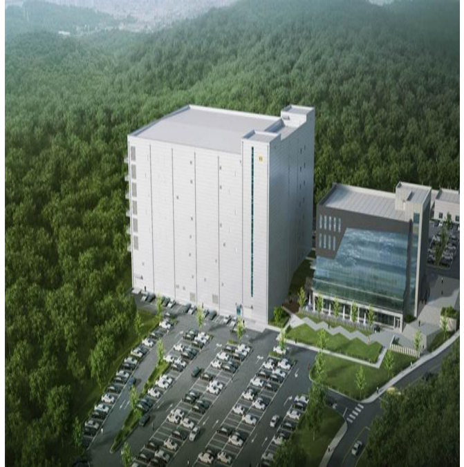
K8 Battery 충방전동 신축공사 중 철골공사
