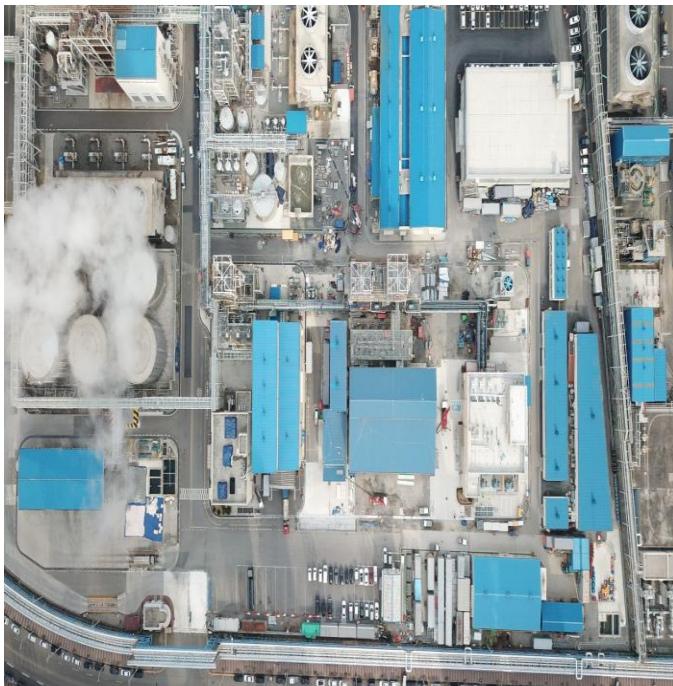
화학 여수 CNT 2차 Project 시공 중 철골공사
