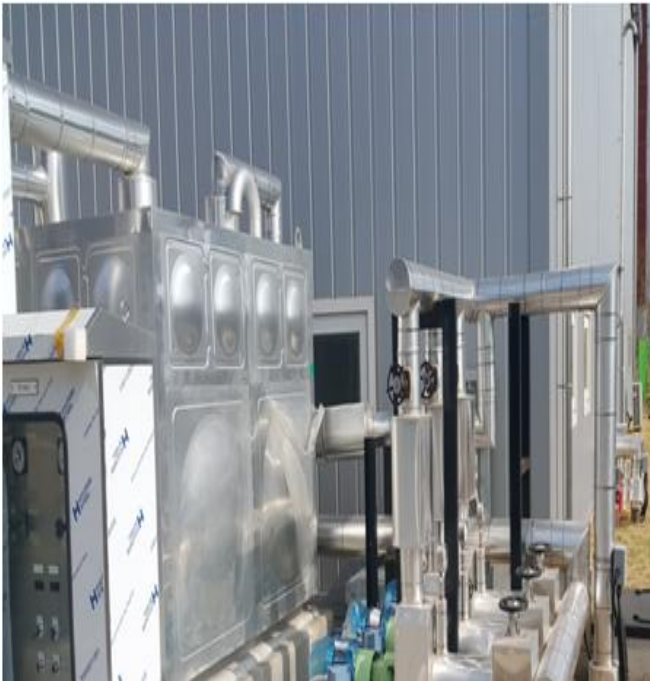
대용량 스택평가장치 전용 설비 및 유틸리티 공사
