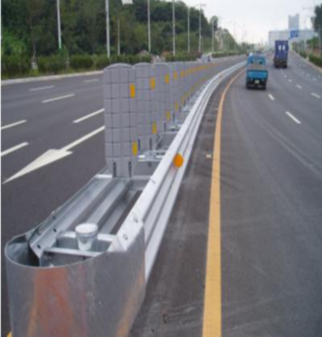
중앙 분리대 공사
