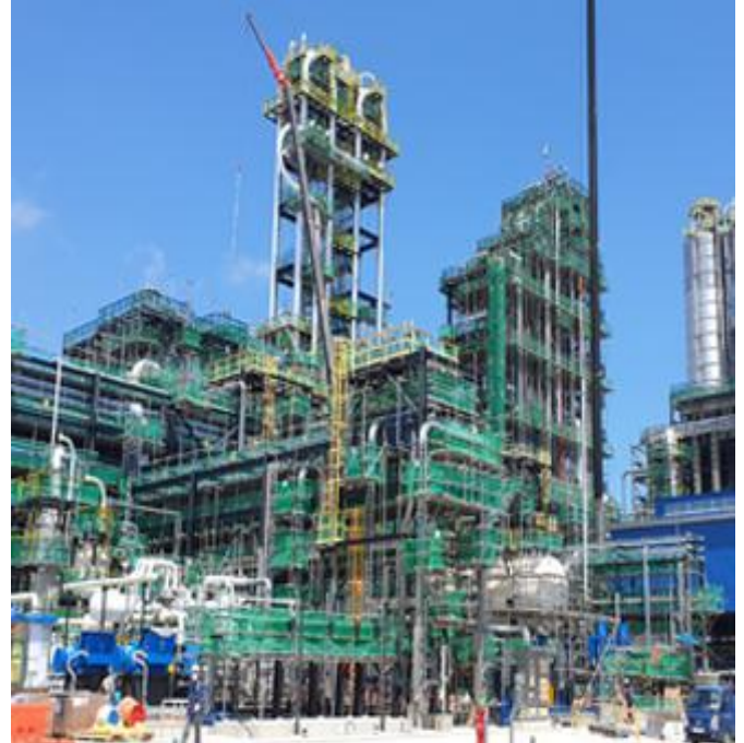
PP - PJT P/R 철골공사
