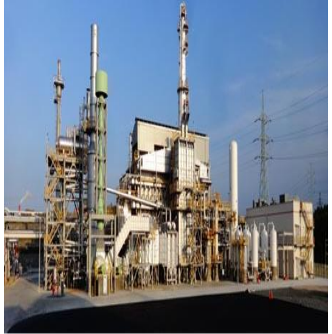
HC PROJECT 중 철골공사
