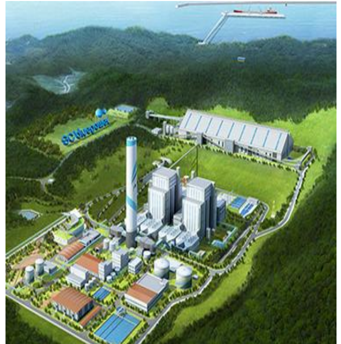
삼척화력발전소 1,2호기 EPC 건설공사 중 철골공사
