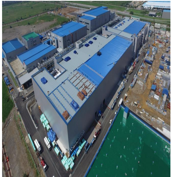
서산 Battery 제2공장 건축공사 중 철골공사
