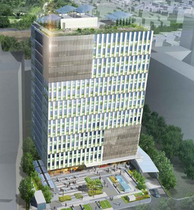
서울숲 M타워 신축공사 철골공사
