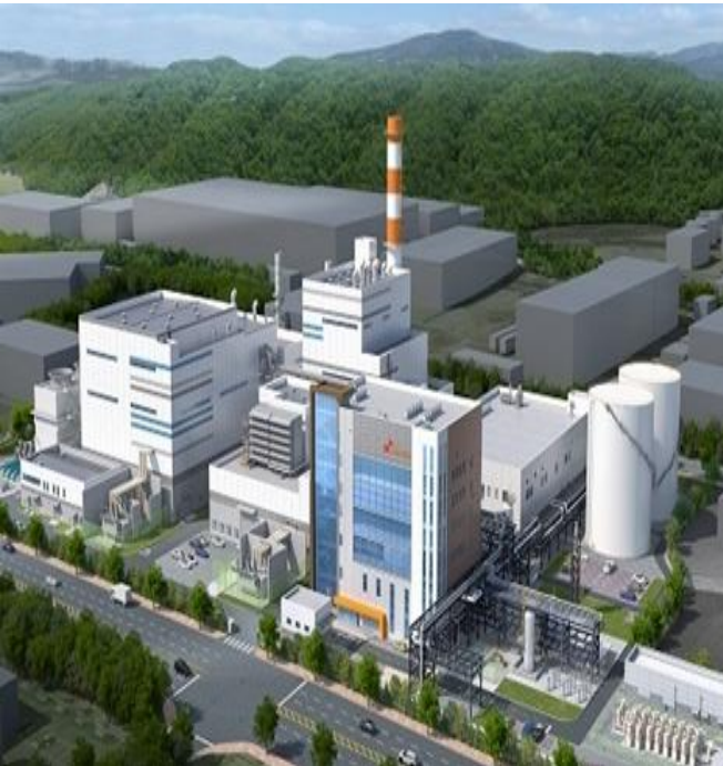
울산 SKMU Project 중 철골공사
