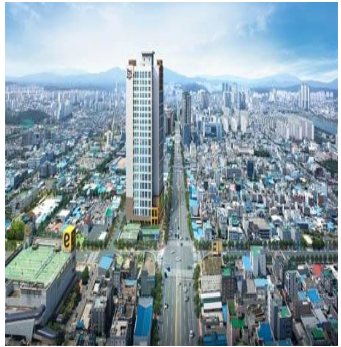
울산남구 삼산동 오피스텔 신축공사 중 철골공사
