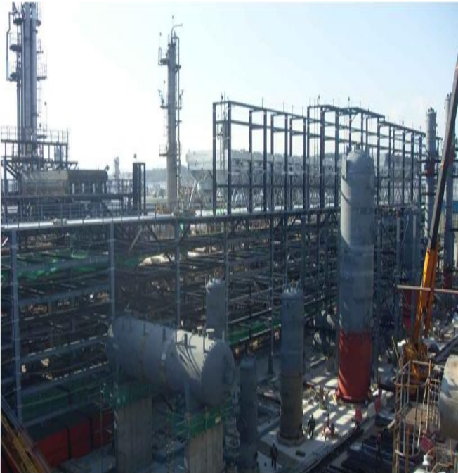
SDA PROJECT 철골공사
