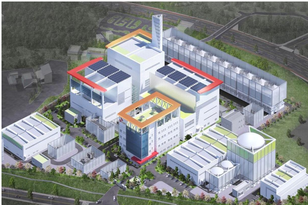
스마트에너지센터 건설 Project (청주)
