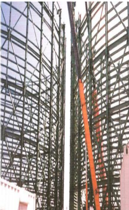
SILO TANK 제작/설치
