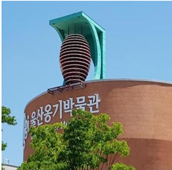
디자인 구조물 설치공사
