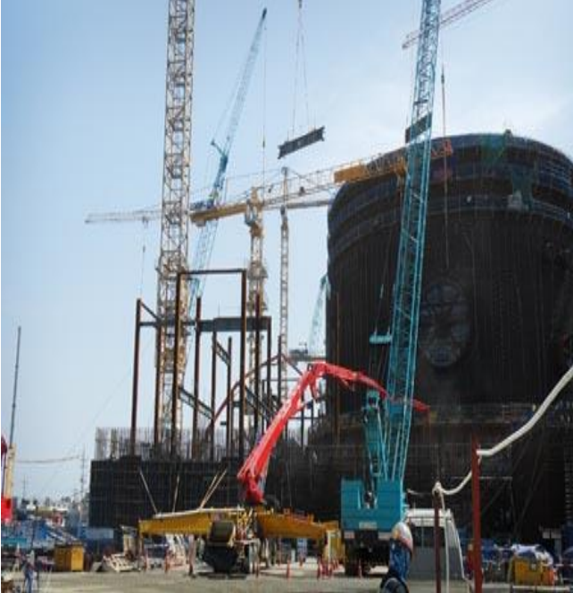
신고리원자력 5,6호기 철골공사 2공구
