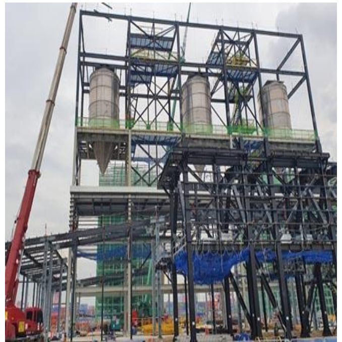
PP - PJT 건축 철골공사
