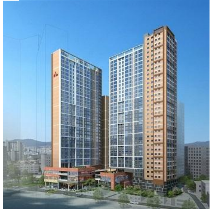
시청역 SK View 주상복합신축공사
