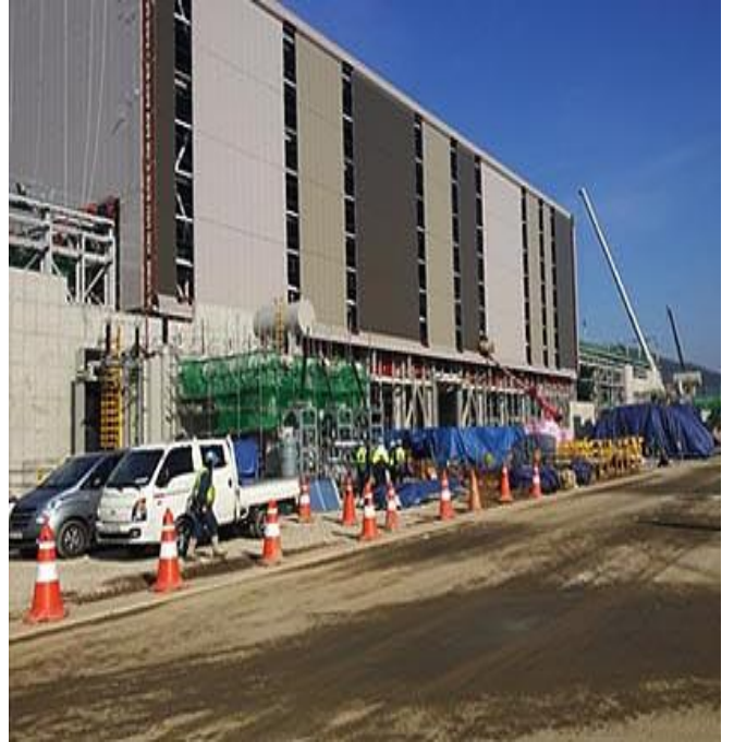
건물 외벽 판넬공사
