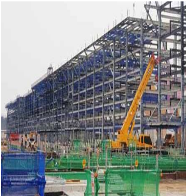
S-Project 중 철골공사 B공구
