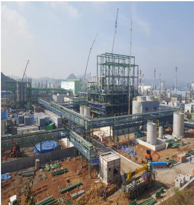
KAK PROJECT용 철골제작 및 설치공사
